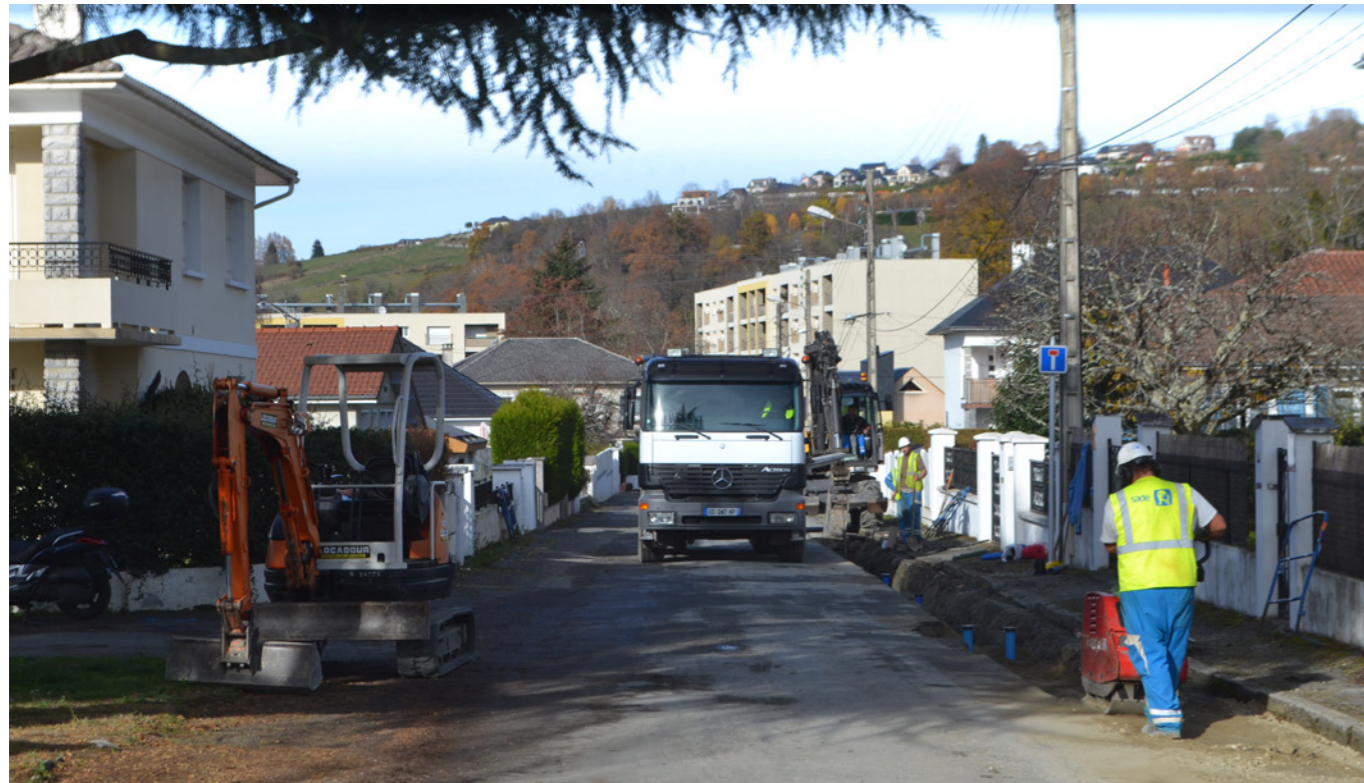
Les travaux devraient s'achever fin février 2019 dans le quartier du Parc Malye.
