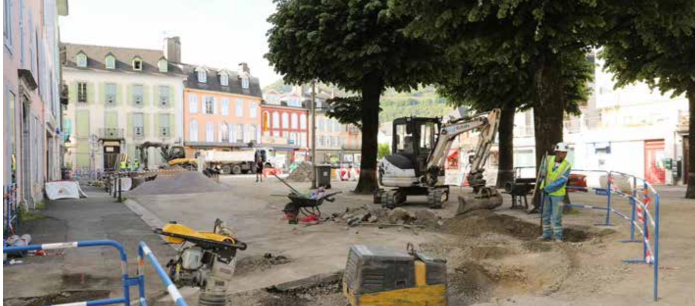
Après quatre mois de travaux, la circulation normale a été rétablie sur les Coustous.
