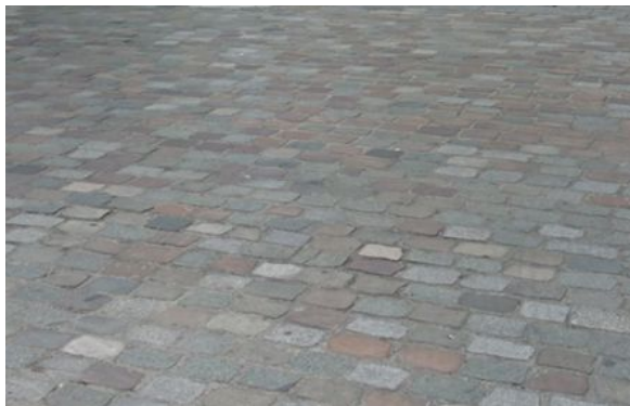
Zone centrale Coustous en pavés de granit
