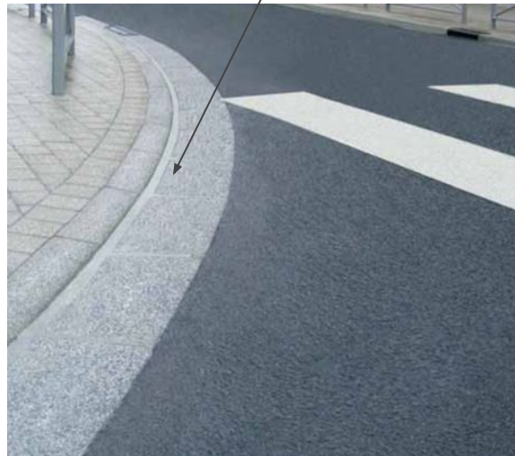
Chaussée et stationnement en béton bitumineux
